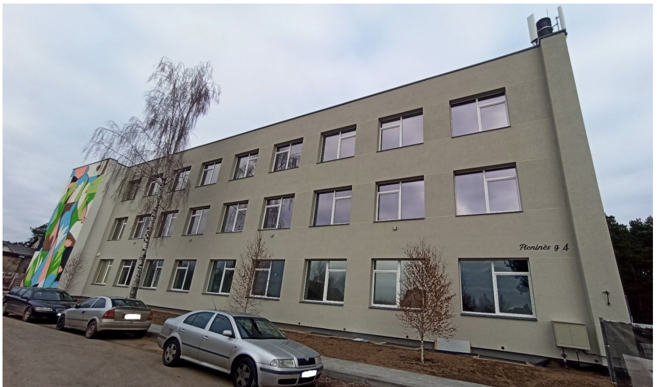
4 pav. Pastato fasadas nuo Pieninės g. pusės.
