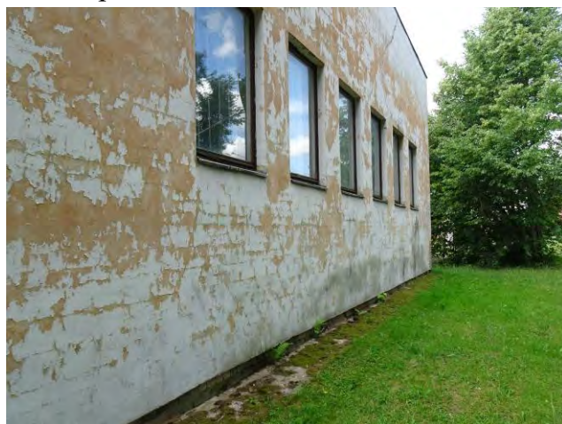
7 pav. Išorinėmis sienomis kyla kapiliarinė drėgmė.
