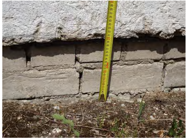
4 pav. Dėl vandens paplaunamų pamatų vietomis nuogrinda nusėdusi iki 20 cm.
