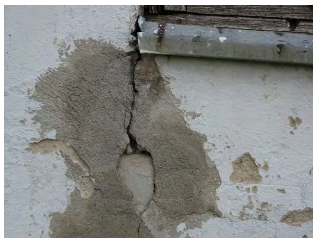
10. Vertikalus plyšys pastato sienos mūre.
