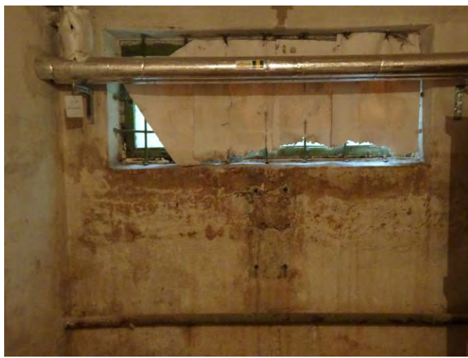
24 pav. Vanduo skverbiasi ties rūšio langu.
