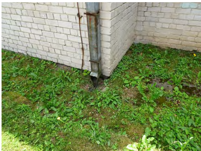
21. Ties dalimi pastato nuogrinda neįrengta.
