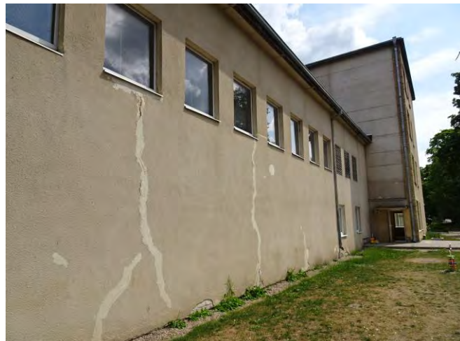
16. Vertikalūs plyšiai pastato sienoje užtinkuoti.
