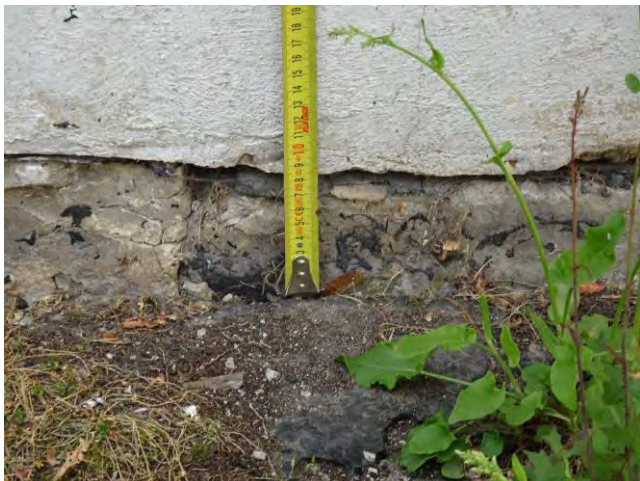
19. Dėl vandens paplovimo nusėdusi pastato nuogrinda.
