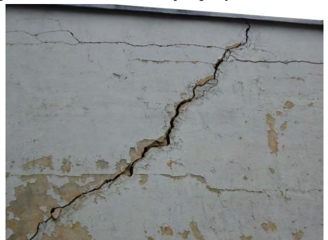
8 pav. Vertikalus plyšys išorinėje pastato sienoje.
