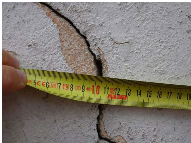
14. Plyšys pastato sienoje, kurio plotis siekia iki 5 mm.
