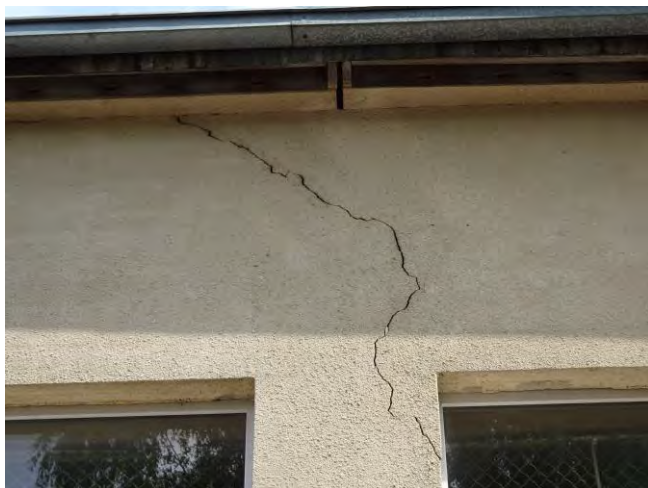
15. Vertikalus plyšys pastato sienoje ties langų angomis.
