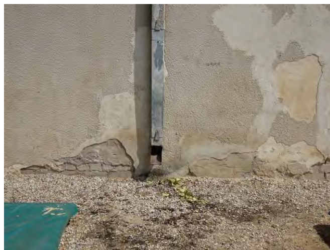
18. Dėl nepakankamo lietaus vandens nuvedimo nuo pamatų drėkinamos pastato sienos. Sienomis kyla drėgmė.
