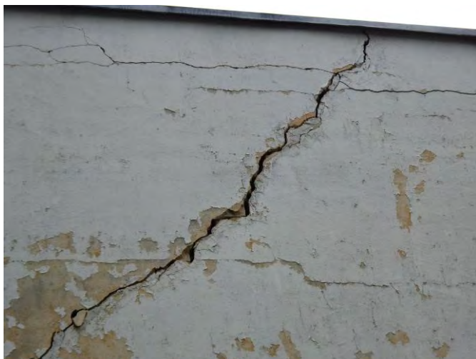
13. Vertikalus plyšys pastato sienoje.
