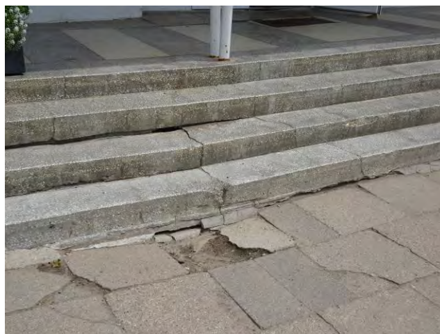
24. Susidėvėję išoriniai pastato laiptai ir plytelių danga.
