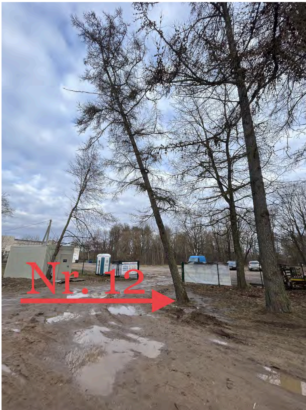
Europinis maumedis (Nr. plane 12) - Stipriai sutankinta augavietė. Kamieno mechaniniai pažeidimai. Kamienas stipriai pasviręs į vakarų pusę. Siūloma šalinti dėl padidėjusios išvirtimo galimybės.
