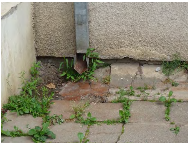
23. Nusėdusi pastato nuogrinda, dėl to drėgmės veikiami pastato pamatai.
