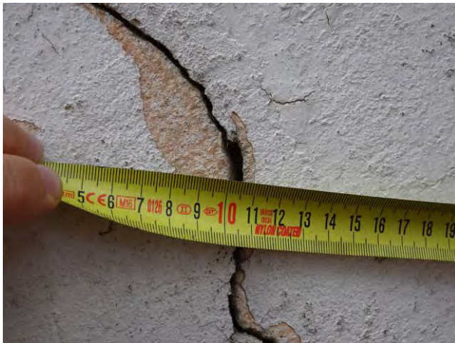
11 pav. Plyšys pastato sienoje, kurio plotis siekia iki 5 mm.
