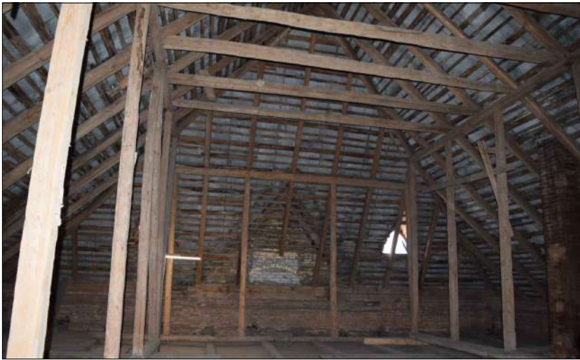
Medinės gegninės-statramstinės stogo konstrukcijos
