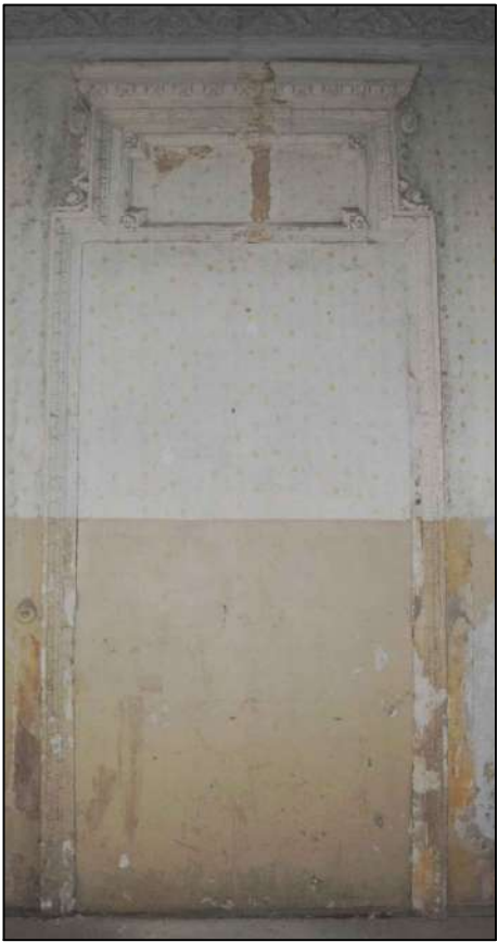
Restauruojama durų anga, pagal tipą remontuojamos medinės profiliuotos įsprūdinės durys. Restauruojami durų ornamentuoti apvada ir supraportai (pagal atskirą programą)
