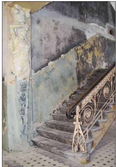
GL.KR, LP_1 - Restauruojamas gipsinis piliastras kariatidė. Restauruojami dirbtinio marmuro laiptai su augalinio motyvo kalto metalo laiptų turėklais T_1 ir mediniu profiliuotu porankiu.
