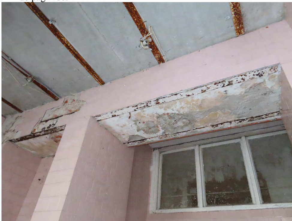
42. Sovietmečio laikotarpiu įrengto priestato tarp ašių 1-3 perdanga iš surenkamų gelžbetoninių perdangos plokščių su tarpuose įrengtomis ~180(h)x90 mm metalinėmis sijomis. Iškirtose sienų angose įrengtos metalinės I 240(h)x115 mm dvitėjinių sijų sąramos.
