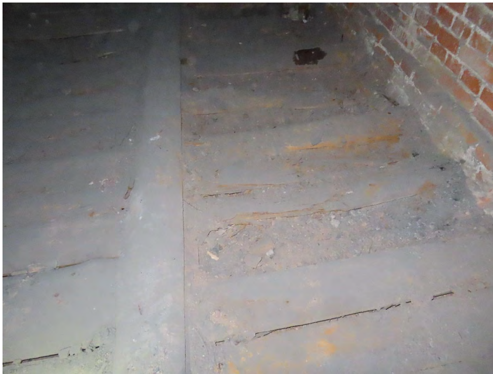
65. Stogo pratekėjimų vietose, antro aukšto perdangos sijos ir lentų paklotas pažeistas puvinio.
