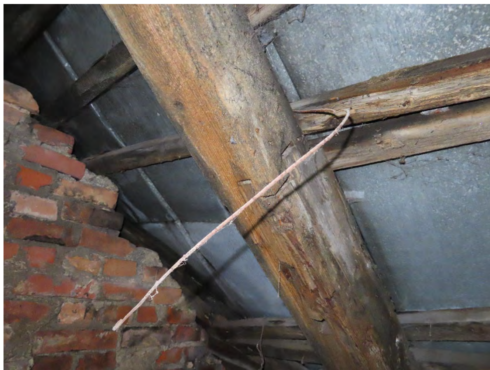
74. Protezuotos gegnės sujungimo mazgas įrengtas netinkamai. Sujungimo mazge atsiradę laisvumai.
