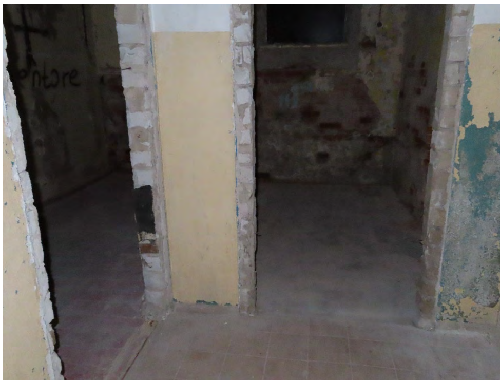
27. Mūrinės pertvaros pusrūsyje ~15 cm storio, išmūrytos iš silikatinių plytų.
