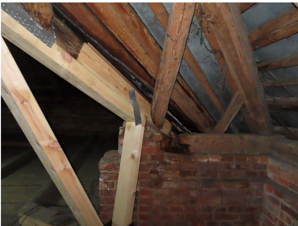
76. Puvinio pažeistos stogo konstrukcijos papildomai sustiprintos 100x100 mm mediniais tašais.
