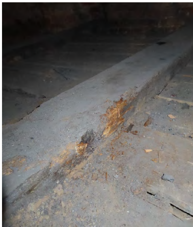
62. Dėl stogo dangos pratekėjimų, perdangos sijos vietomis pažeistos puvinio ir sumažėjusio skerspjūvio.
