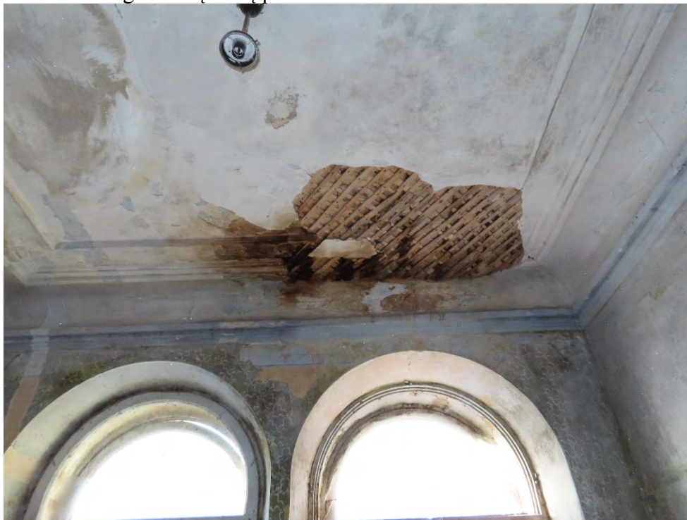
60. Stogo pratekėjimų vietose medinės perdangos konstrukcijos ir paklotai pažeisti drėgmės ir puvinio, pažeistas tinkas atšokęs nuo pagrindo ir vietomis nukritęs.
