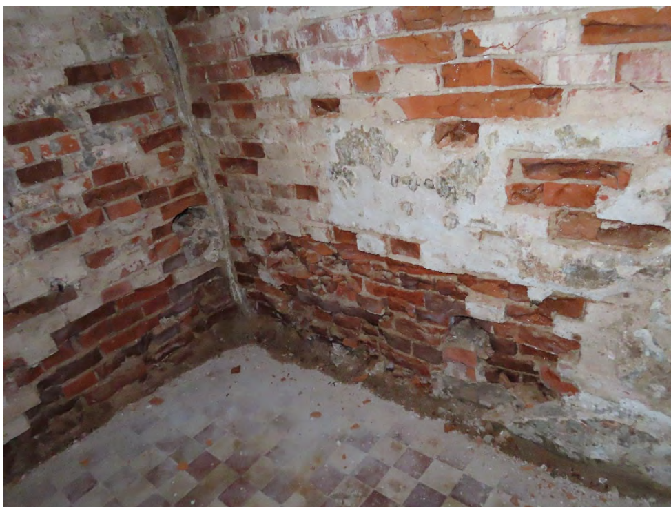
25. Pamatai įrengti be vertikalios hidroizoliacijos, pusrūsio lauko sienų mūras iki 0,5 plytos storio eroduotas, mūras drėgnas ir užterštas tirpiomis druskomis.
