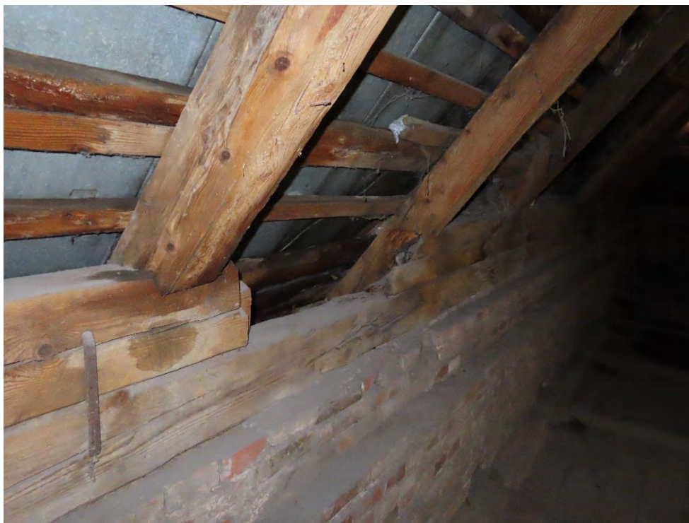
75. Stogo pratekėjimo vietoje dalis mūrtašio supuvę, grebėstų paklotas ir gegnių galai pažeisti puvinio.
