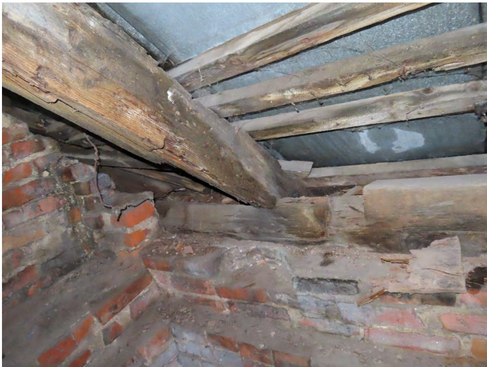
71. Stogo pratekėjimų vietose karnizo dalyje mūrtašis ir gegnė pažeista puvinio.
