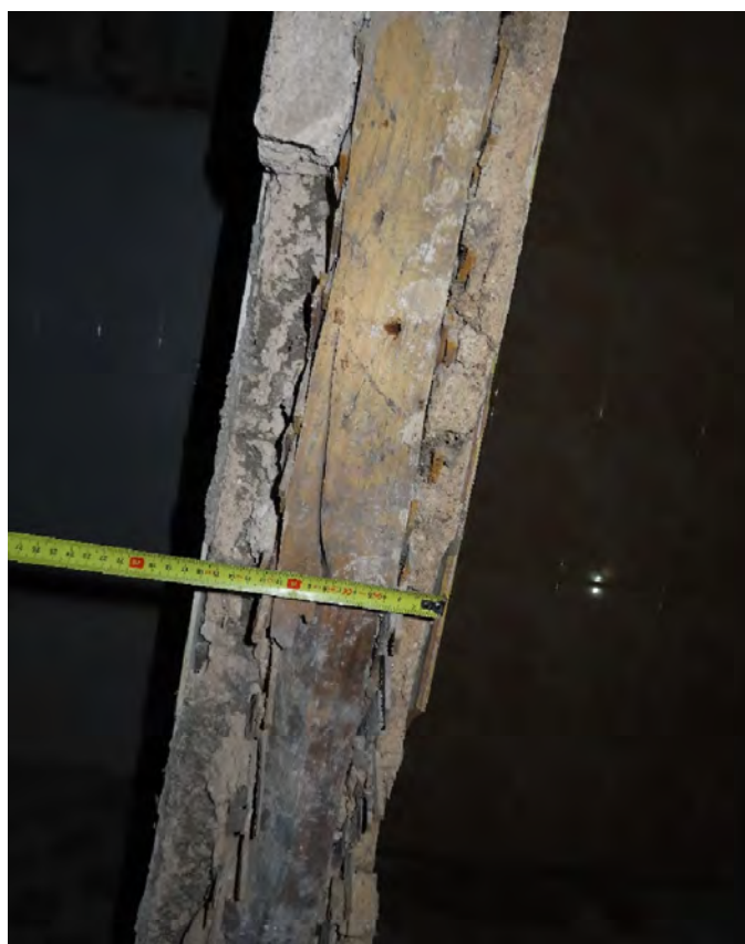
26. Medinės pertvaros pusrūsyje ~16-17 cm storio. Pertvaros iš abiejų pusių tinkuotos ant balanų, tinkas atšokęs nuo pagrindo ir sutrūkinėjęs. Medinis karkasas pažeistas puvinio
