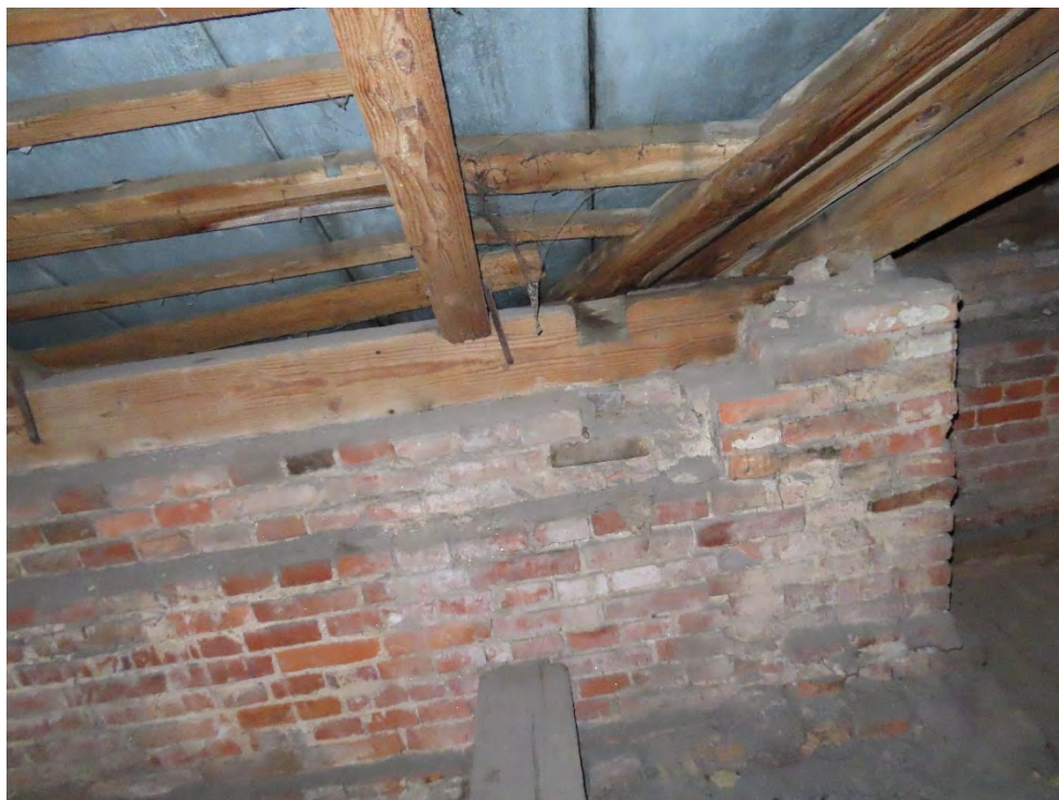
69. Stogo remonto metu buvo pakeista stogo danga ir gegnės. Mūrtašyje išlikusios išpjovos buvusių gegnių vietose.
