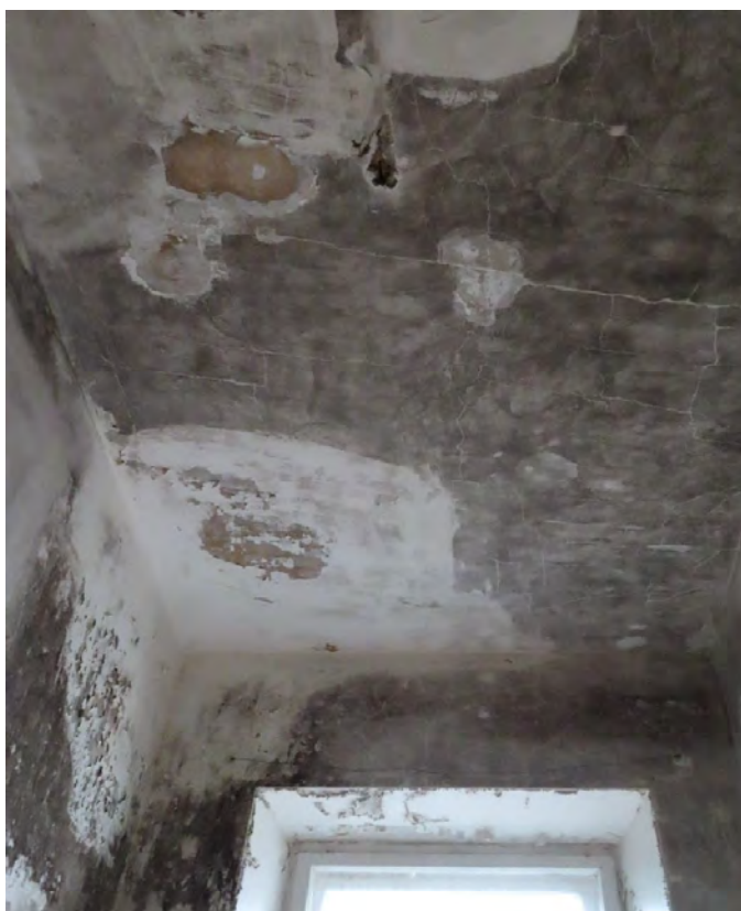
49. Stogo pratekėjimų vietose lubų ir sienų tinko apdaila pažeista drėgmės. Pažeistas tinkas lubose sutrūkinėjęs ir atšokęs nuo pagrindo.
