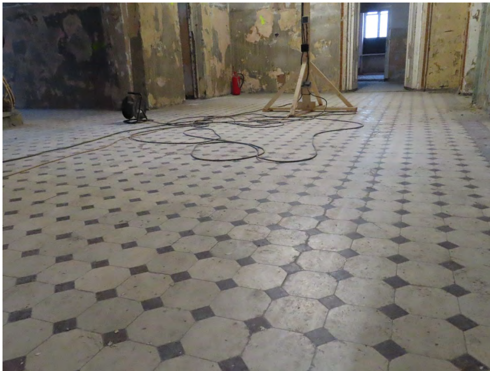
37. Pirmo aukšto vestibulyje grindys išklotos metlacho plytelėmis. Grindų konstrukcija ~10cm patalpos viduryje pasėdusi.
