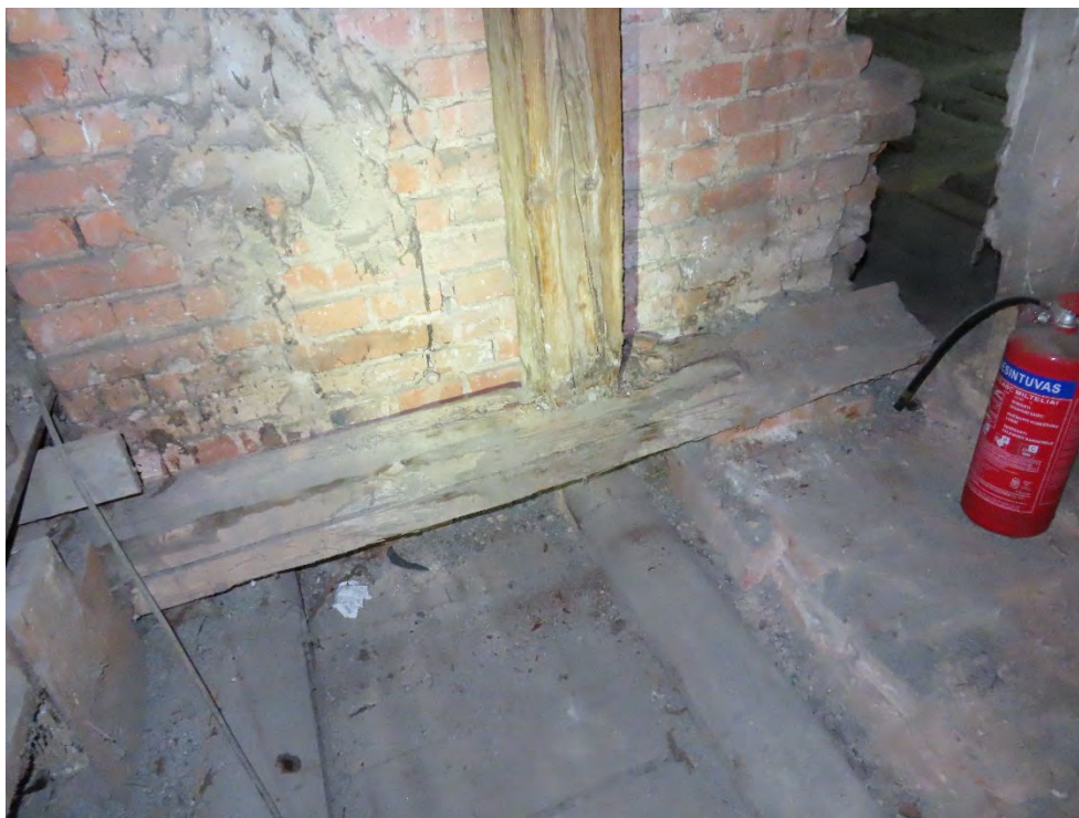
70. Statramsčio ir ilginio kontakto vietoje mediena pažeista puvinio.
