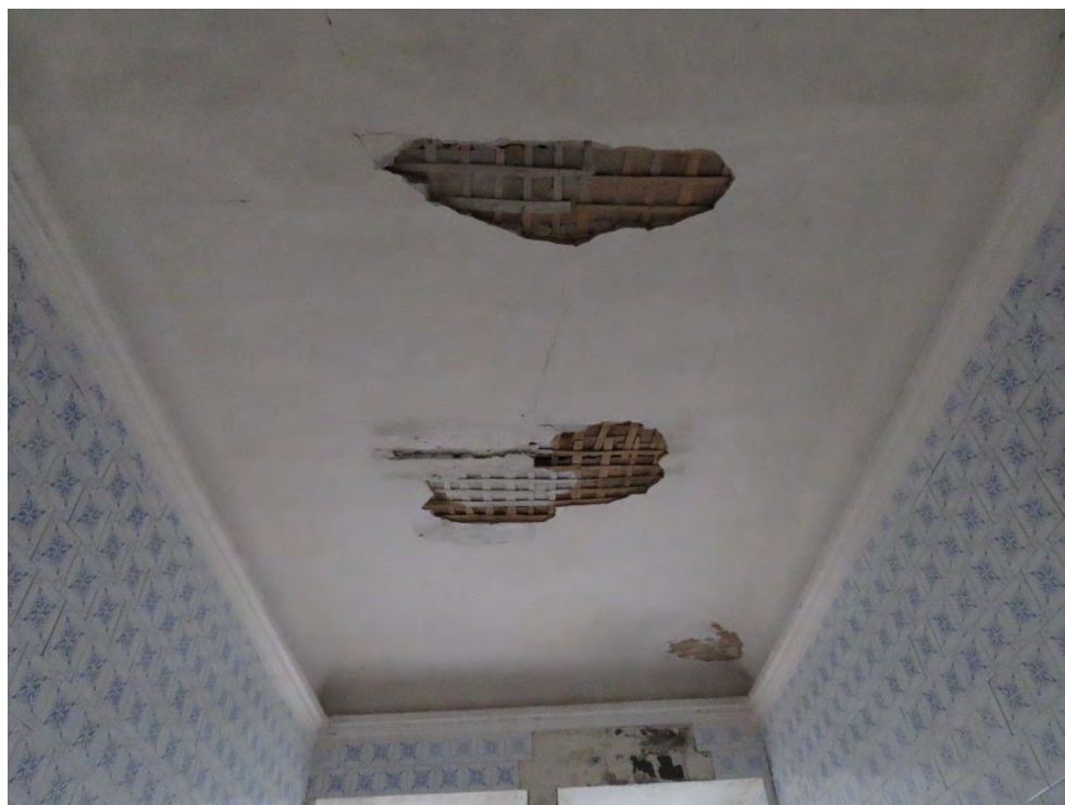
56. Stogo pratekėjimų vietose drėgmės pažeistas tinkas atšokęs nuo pagrindo ir vietomis nukritęs.
