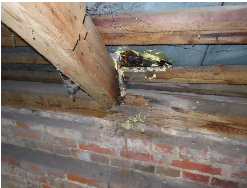
77. Stogo pratekėjimo vietoje 200x200 mm mūrtašis, grebėstų paklotas ir gegnės 180(h)x140 galas pažeisti puvinio. Protezuotos gegnės sujungimo mazgas įrengtas netinkamai. Sujungimo mazge atsiradę laisvumai.
