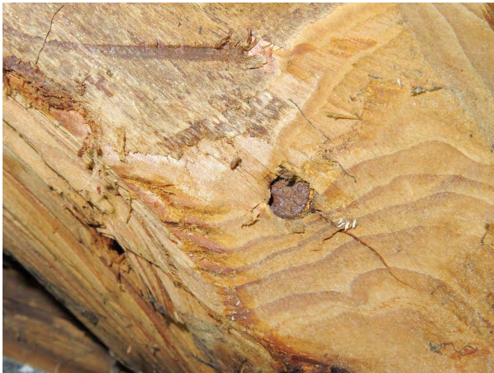
73. Stogo medinių konstrukcijų sujungimui buvo naudojamos gamyklinės presuotos vinys.
