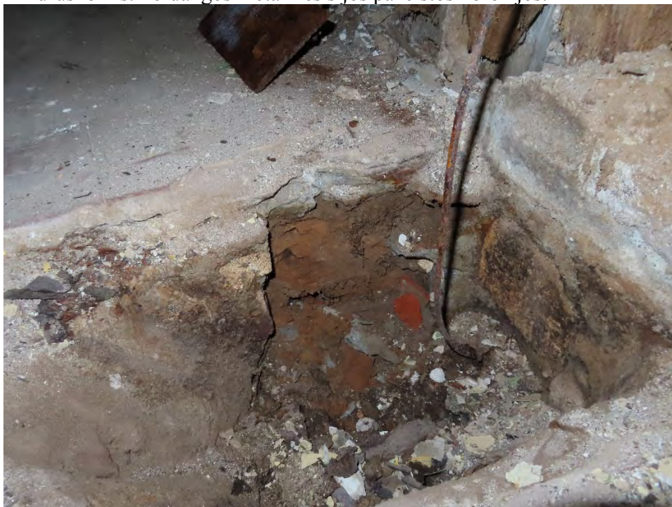
24. Zondažas nr.1. Pusrūsyje ant sutankinto grunto įrengtas 7 cm betono sluoksnis su 1 cm keraminių plytelių apdaila.
