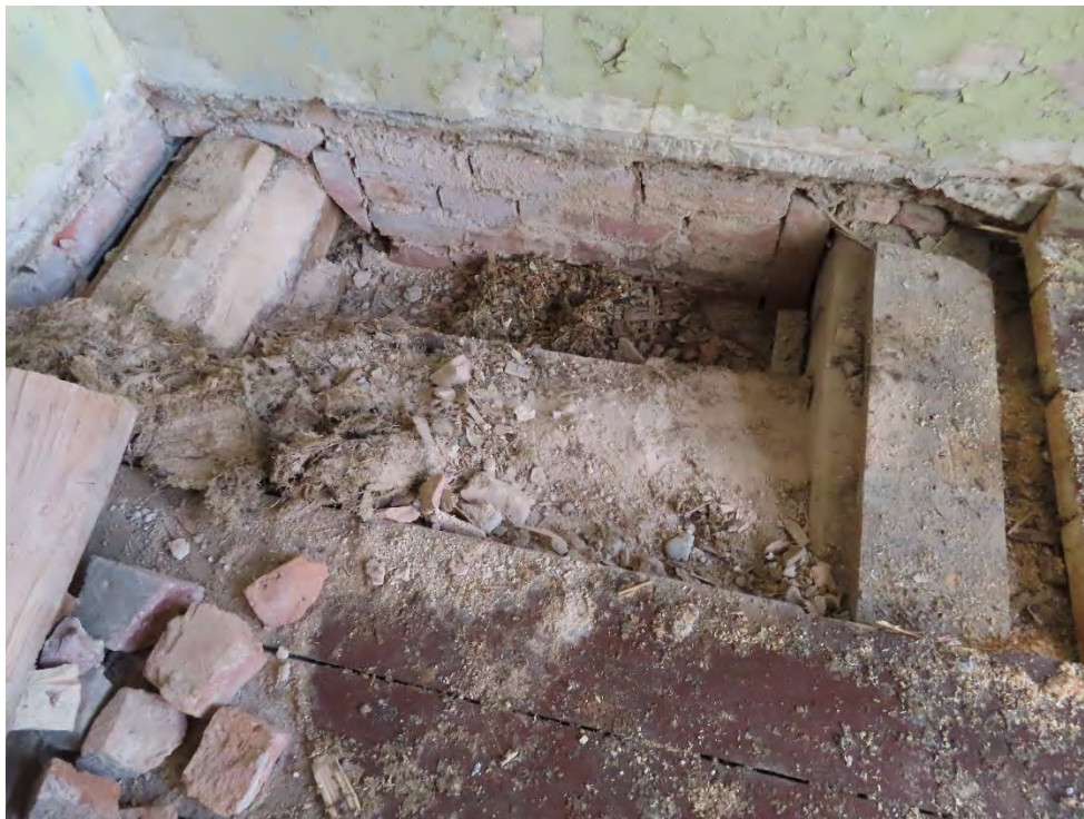
59. Zondažas nr. 6. Medinės perdangos sijos 240(h)x200 mm, išdėstytos ~1,0 m žingsniu. Tarp sijų ant 35 mm lentų pakloto įrengtas ~150 mm samanų ir statybinio laužo užpildas. Ant sijų įrengti mediniai gūlekšniai 150(h)x40 mm ir 40 mm grindinių lentų paklotas.
