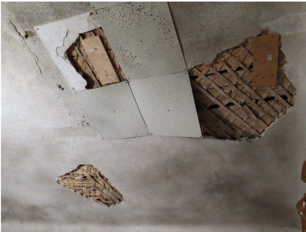
54. Stogo pratekėjimų vietose drėgmės pažeistas tinkas atšokęs nuo pagrindo ir vietomis nukritęs.
