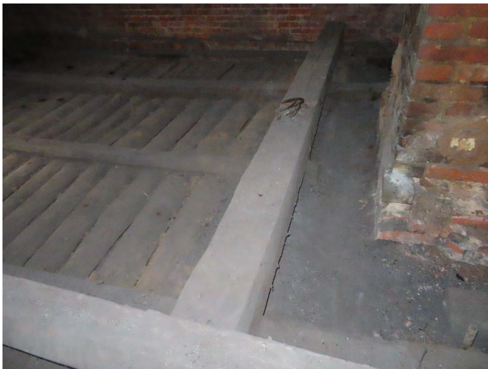
63. Ties dūmtraukiu nupjauta medinė perdangos sija iškabinta ant papildomai įrengtos medinės sijos.
