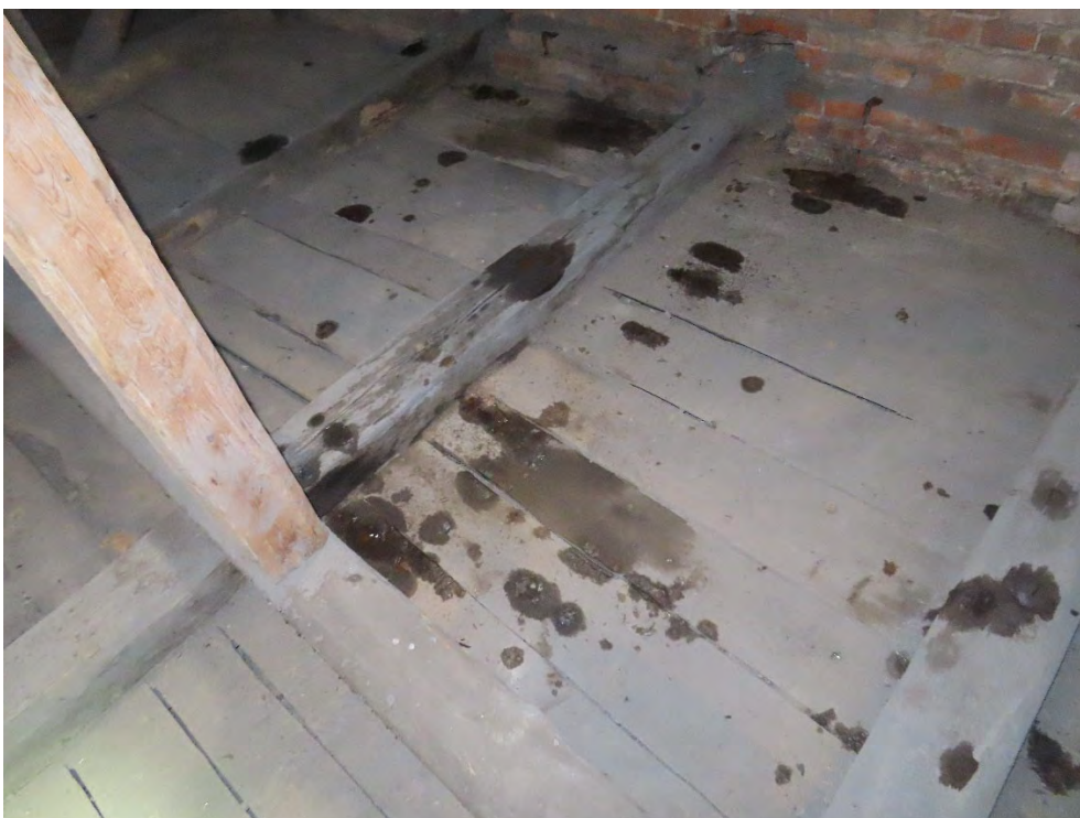
64. Stogo danga daugelyje vietų yra nesandari, matomos pratekėjimų pėdsakai ant antro aukšto perdangos konstrukcijų.
