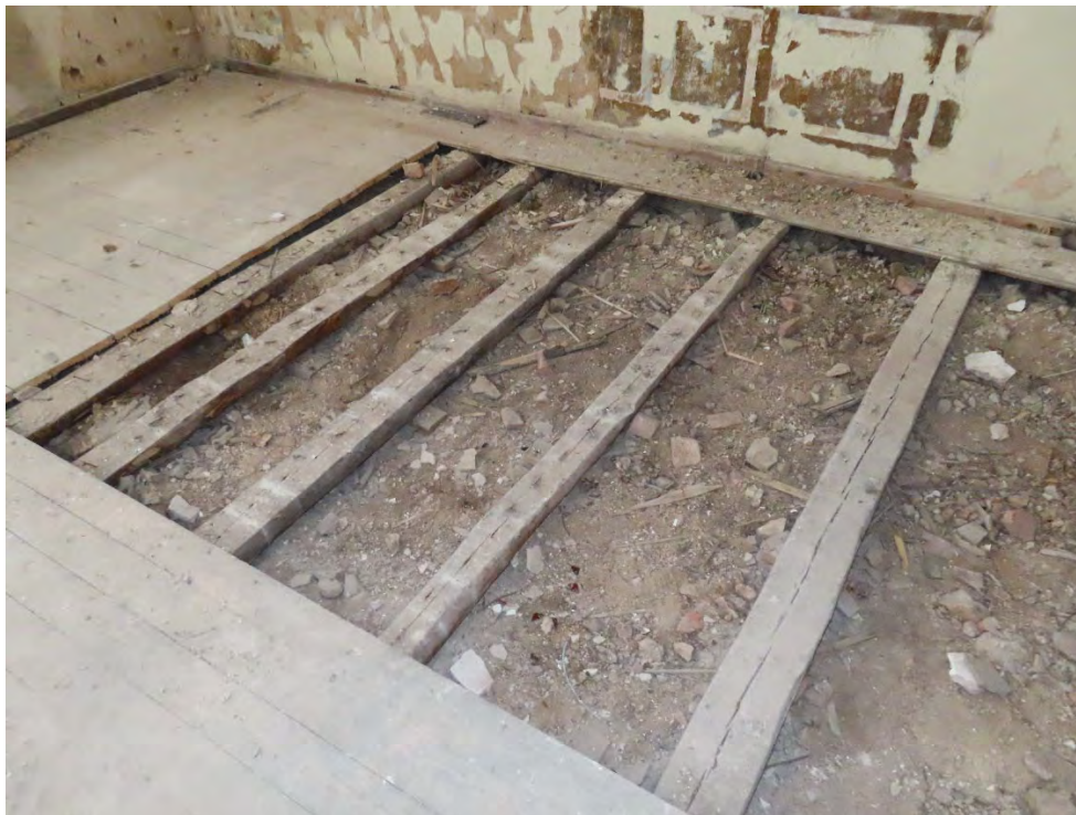
43. Zondazas nr.3. 3 cm storio grindinės lentos įrengtos ant medinių 100(h)x180 mm gulekšnių, išdėstytų ~50-60 cm žingsniu. Gulekšniai pakloti ant statybinio laužo ir mūrinių skliautukų tarp metalinių sijų.
