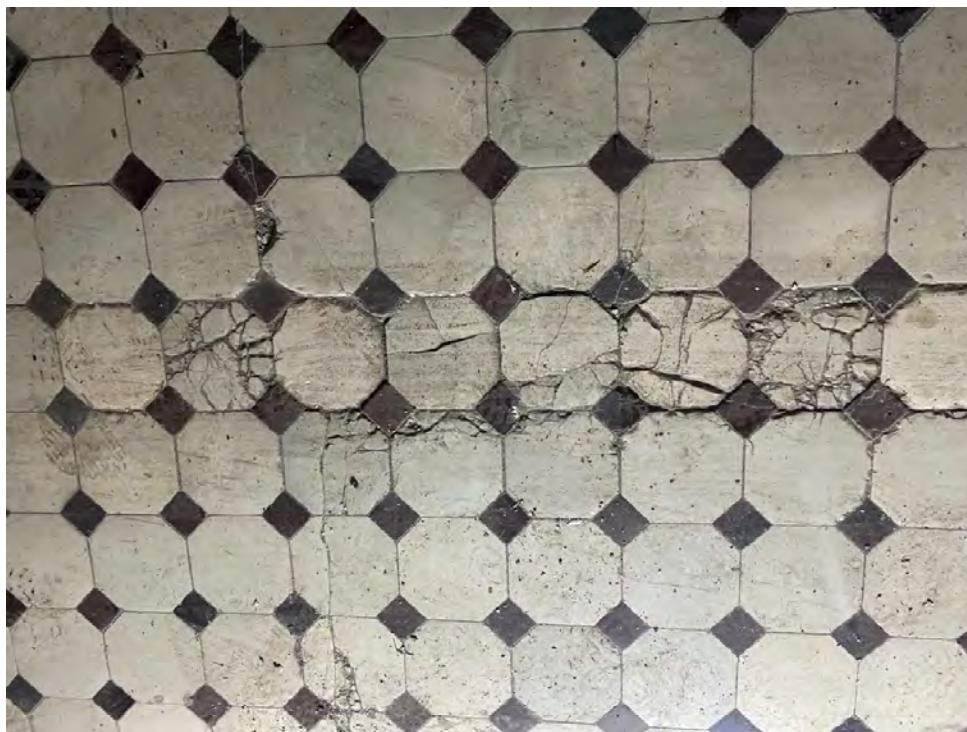
39. Metlacho plytelės sutrūkinėjusios ir atšokusios nuo pagrindo, fragmentai suskaldyti, būtina keisti naujais gaminiais.
