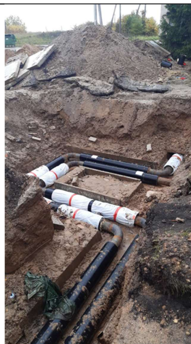
8 pav. Rekonstruota šilumos trasa
