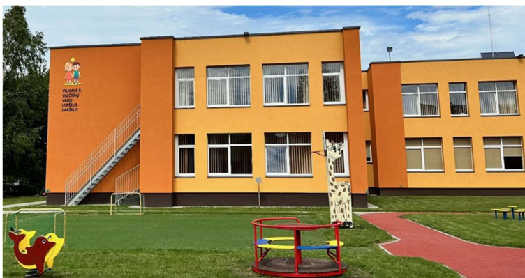
Valčiūnų vaikų lopšelio-darželio atnaujinimas ir modernizavimas
