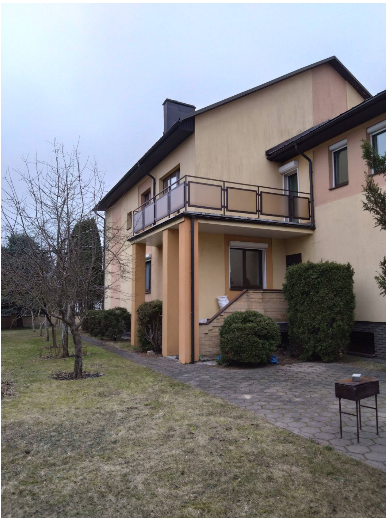
Fotofiksacija iš šiaurės-rytų pusės
