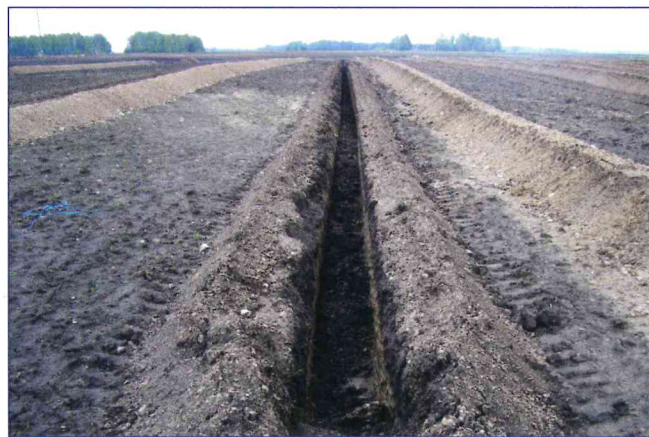
Drenažo sistemos rekonstrukcija
