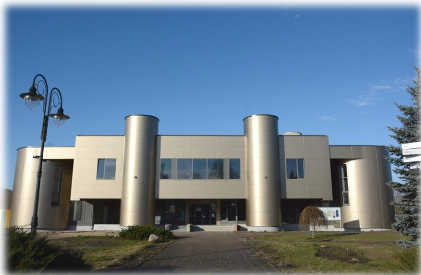
4 pav. Modernizuojamas NDKC
