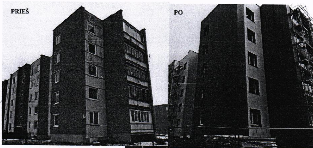
Sodų g. 33, Skaidiškių k., Vilniaus r. atnaujinimo modernizavimo darbai
